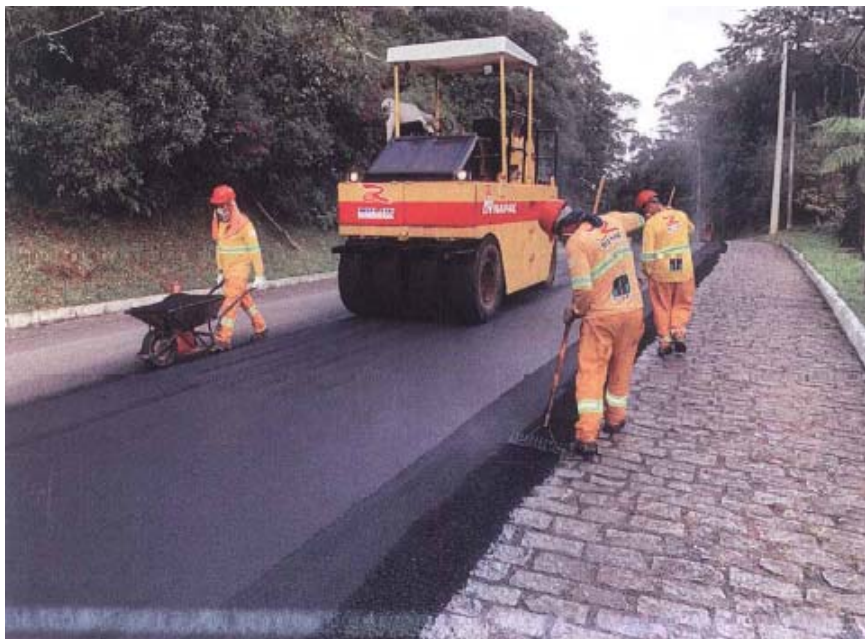
Foto 3 – Restauração do Pavimento – Km 65 ao 67 [2]
