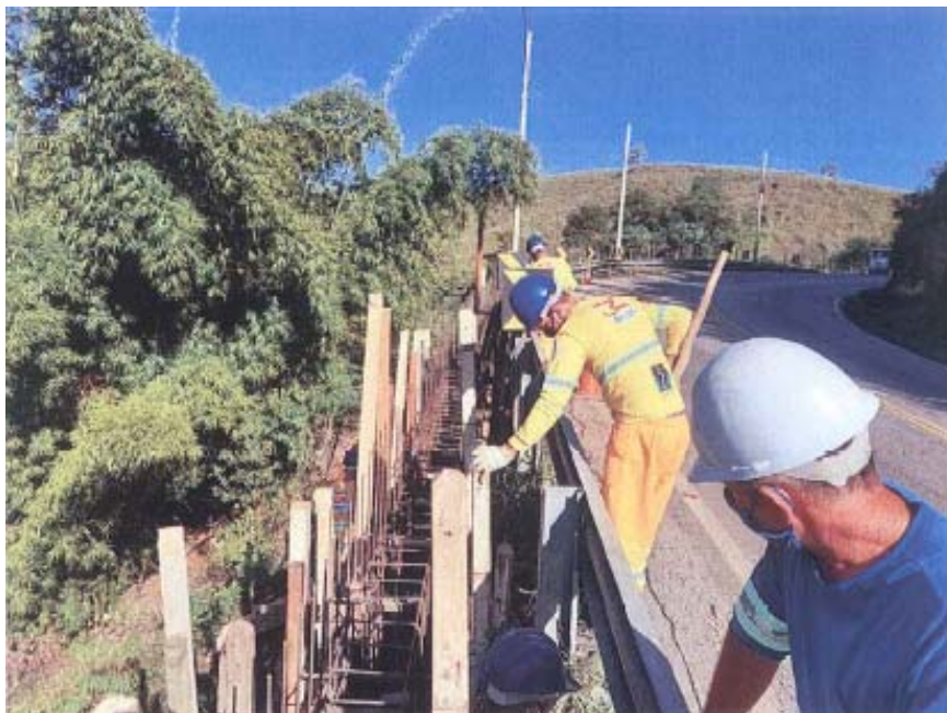
Foto 5 – Restauração de Dispositivo de Segurança – 132+500
