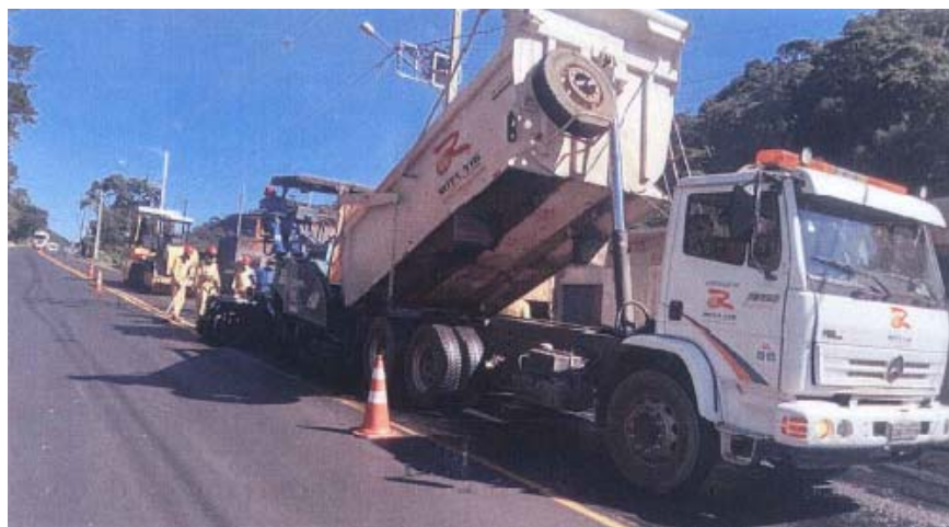
Foto 2 – Restauração do Pavimento – Km 65 ao 67 [1]
