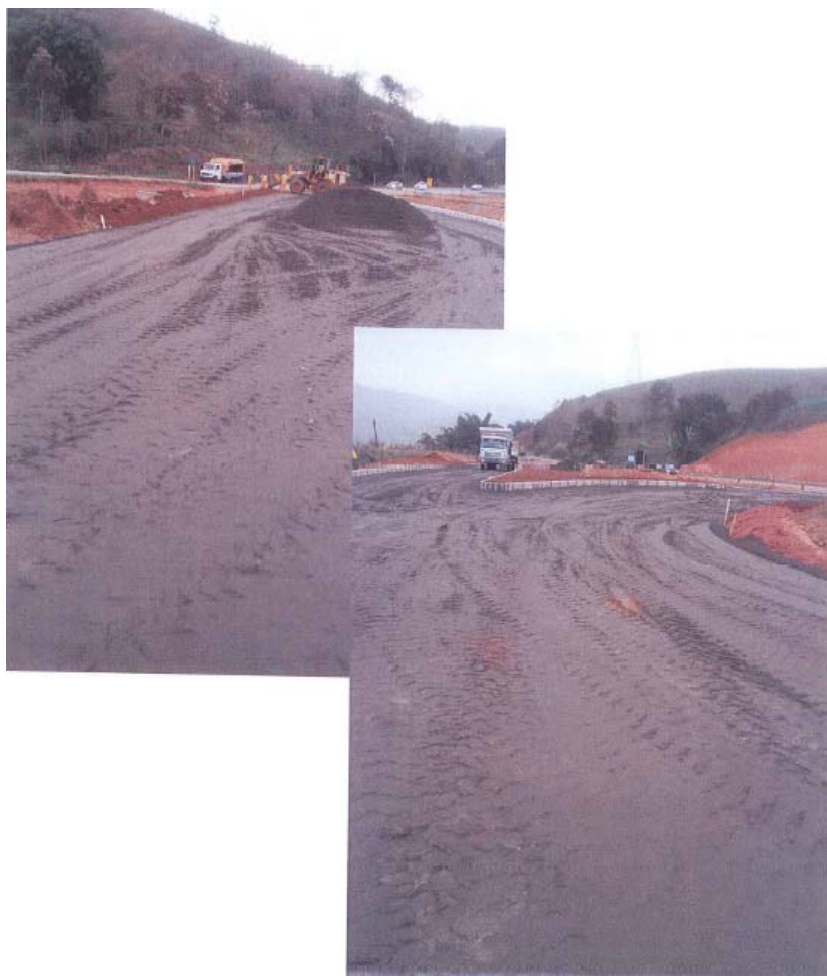
Foto 1 – Adequação da Interseção Cordeiro A – Km 123+300
