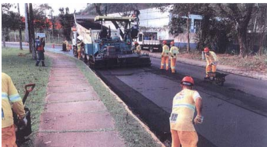
Foto 4 – Restauração do Pavimento – Km 83
